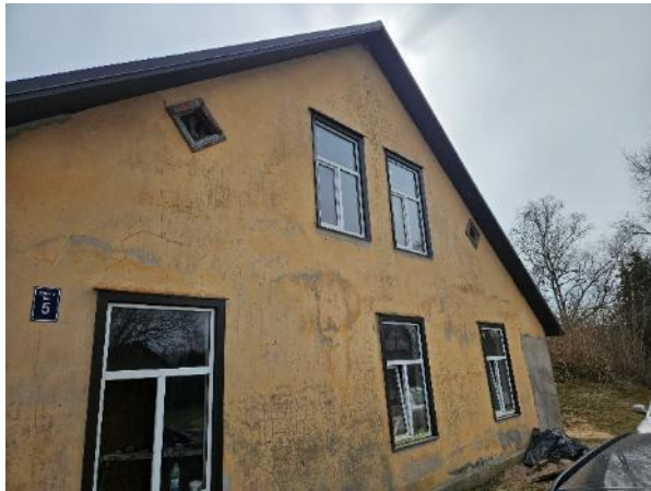
Ēkas fasāde ar dzīvokļa logiem
