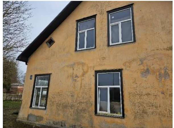
Ēkas fasāde ar dzīvokļa logiem
